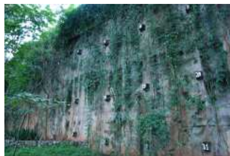
Cortina atirantada localizada na praça do final da pista de cooper
