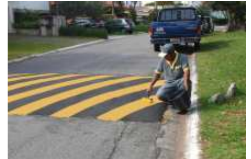
A equipe de Manutenção realizou em fevereiro a recuperação das 93 lombadas internas do Residencial. O trabalho incluiu a recuperação do piso e pintura de faixas de sinalização
