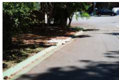
Novos bueiros na alameda São Simão reduzem riscos de alagamento no ponto mais baixo da alameda Franca
