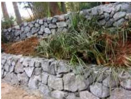
Novo muro de arrimo substitui um antigo muro construído em madeira em 2001
