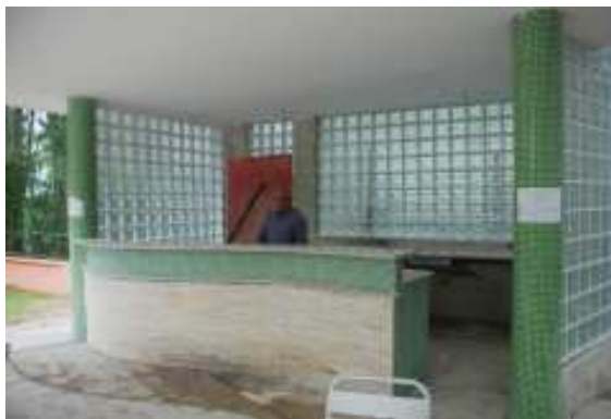
Obras do Espaço Gourmet das quadras de tênis entram na reta final
